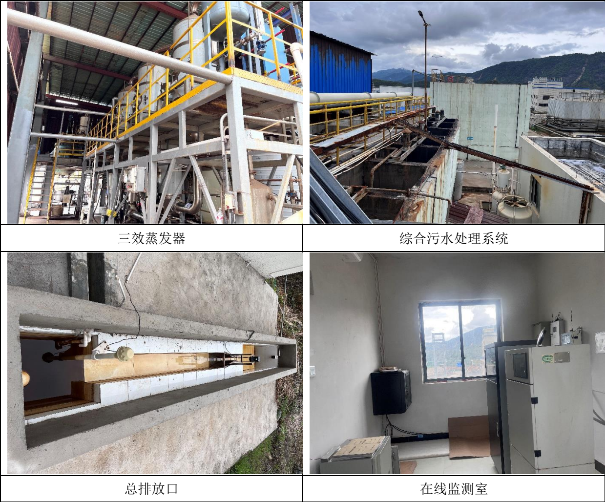
图 4.1-2 废水防治措施现场照片
